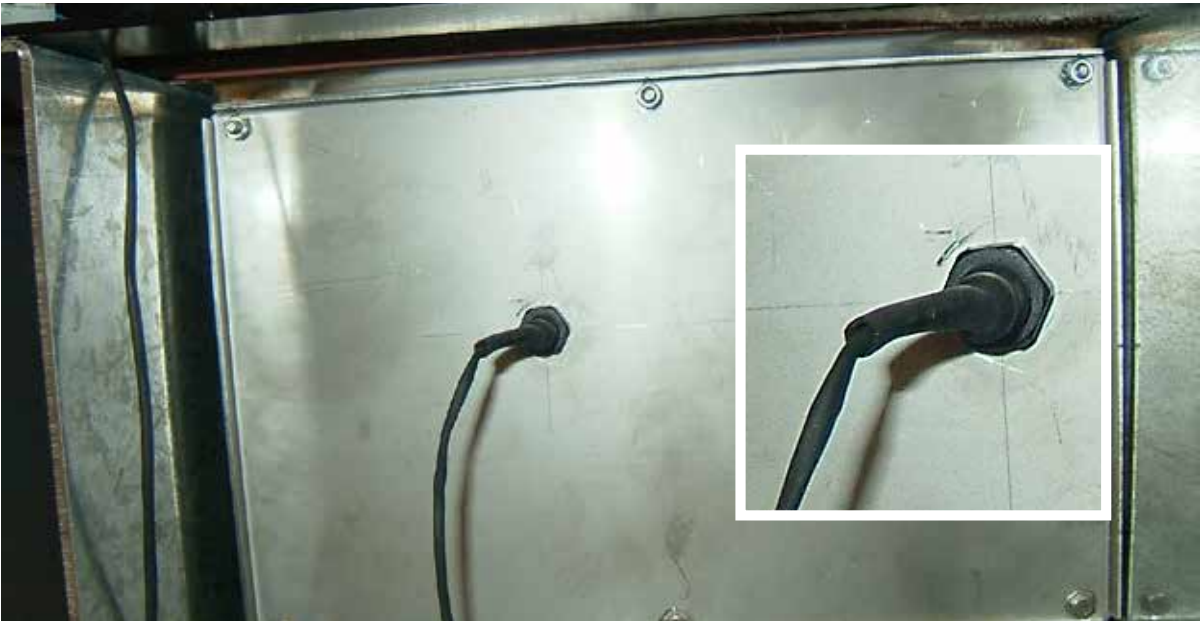
Положение датчика уровня конденсата
